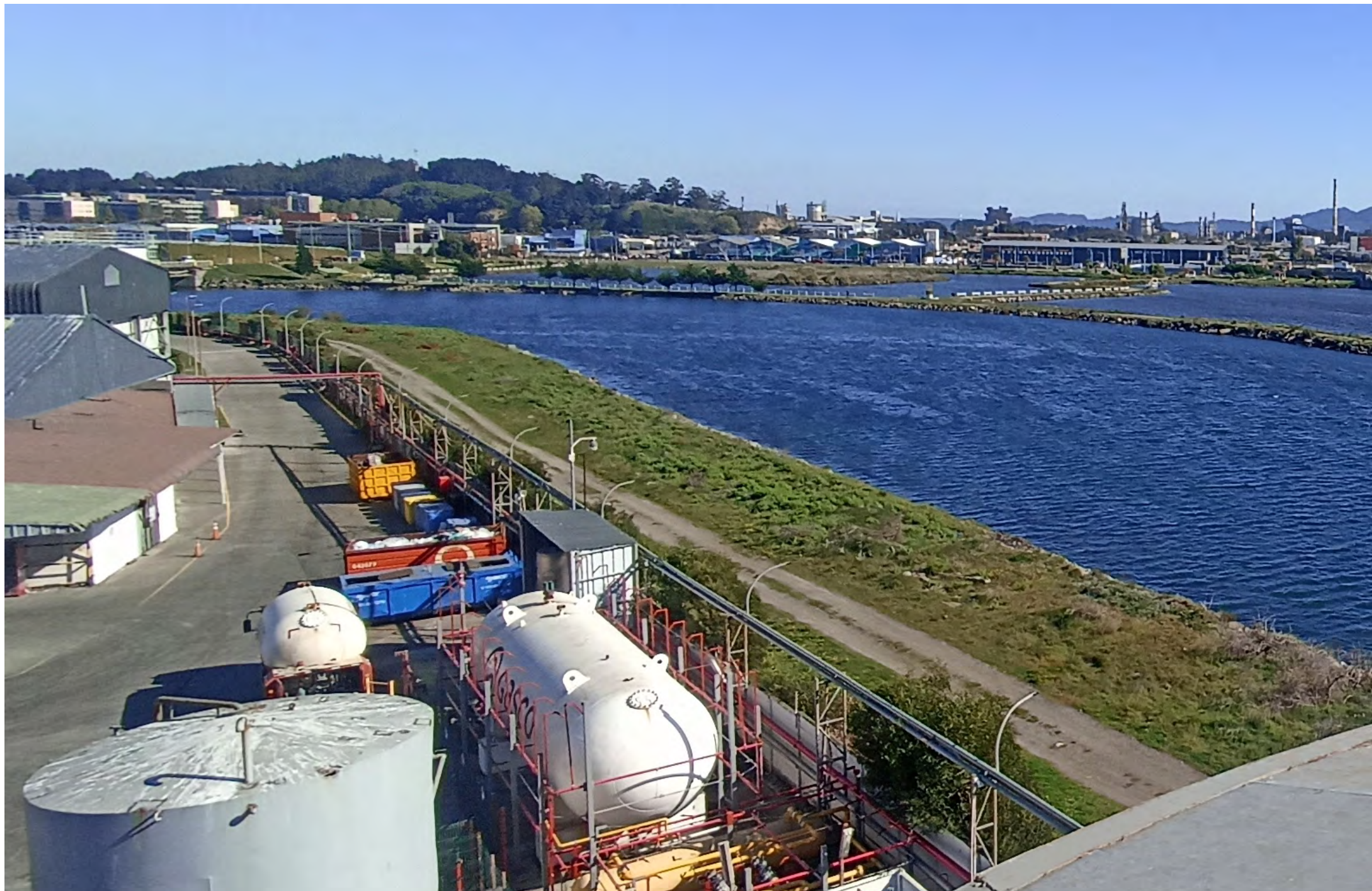
Fotografía: Medición de olores , Sello Integridad, Arturo Beltrán, Superficie estanque N° 6 Planta Talcahuano.
